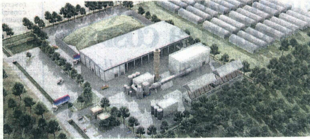
MODELLO Simulazione grafica del progetto con al centro la centrale immersa tra i pioppi. A destra le serre per gli ortaggi
